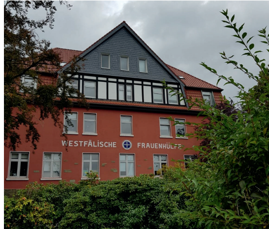
Das rote Haus in Soest, erbaut 1911 für die Westfälische Frauenhilfe.
